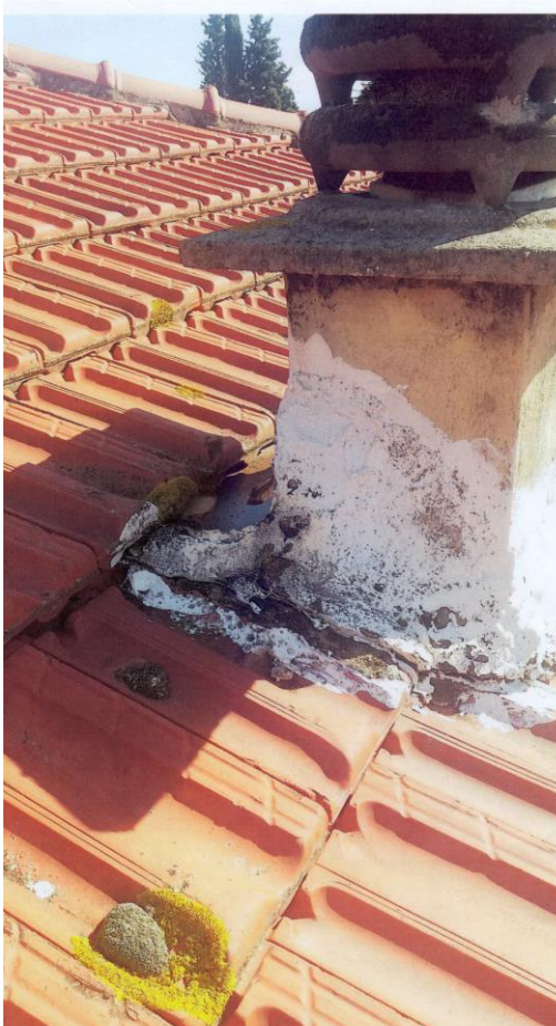
Εικ.3, 4. Φθορές στις ενώσεις των καμινάδων και των ηλιακών συλλεκτών
