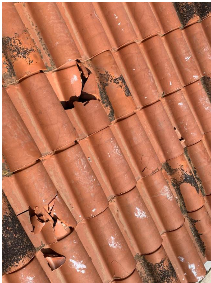
Φωτ.1 Σπασμένα και ρηγματωμένα κεραμίδια
